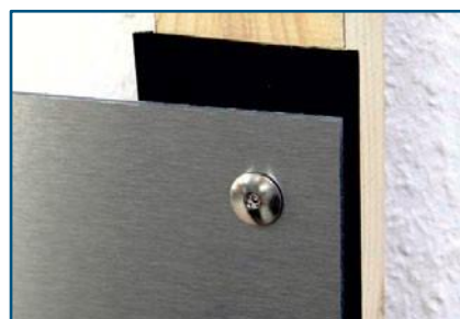
Abb. 13 - fertig erstellter Befestigungspunkt
