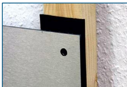
Abb. 8 - Platte mit Bohrung Ø 9,5 mm in Position
