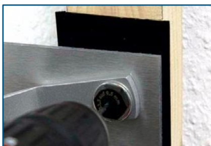
Abb. 9 - Einsatz Bügelbohrvorrichtung, Vorbohren der Holz-UK
