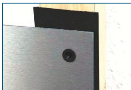
Abb. 11 - Gleitpunkt: Fa-Ze-Di-Ring in Plattenbohrung
